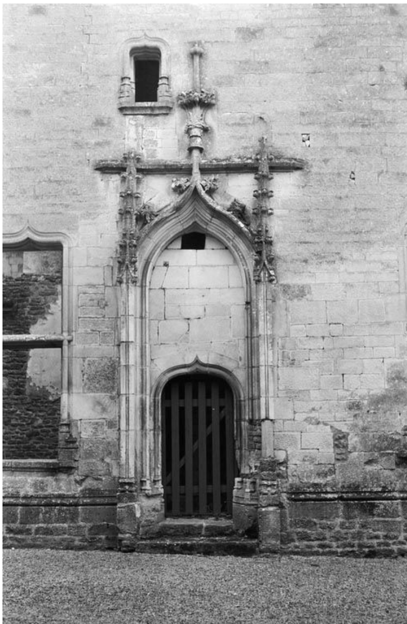
Porte principale du logis des Hôtes (photo prise en 1969).
