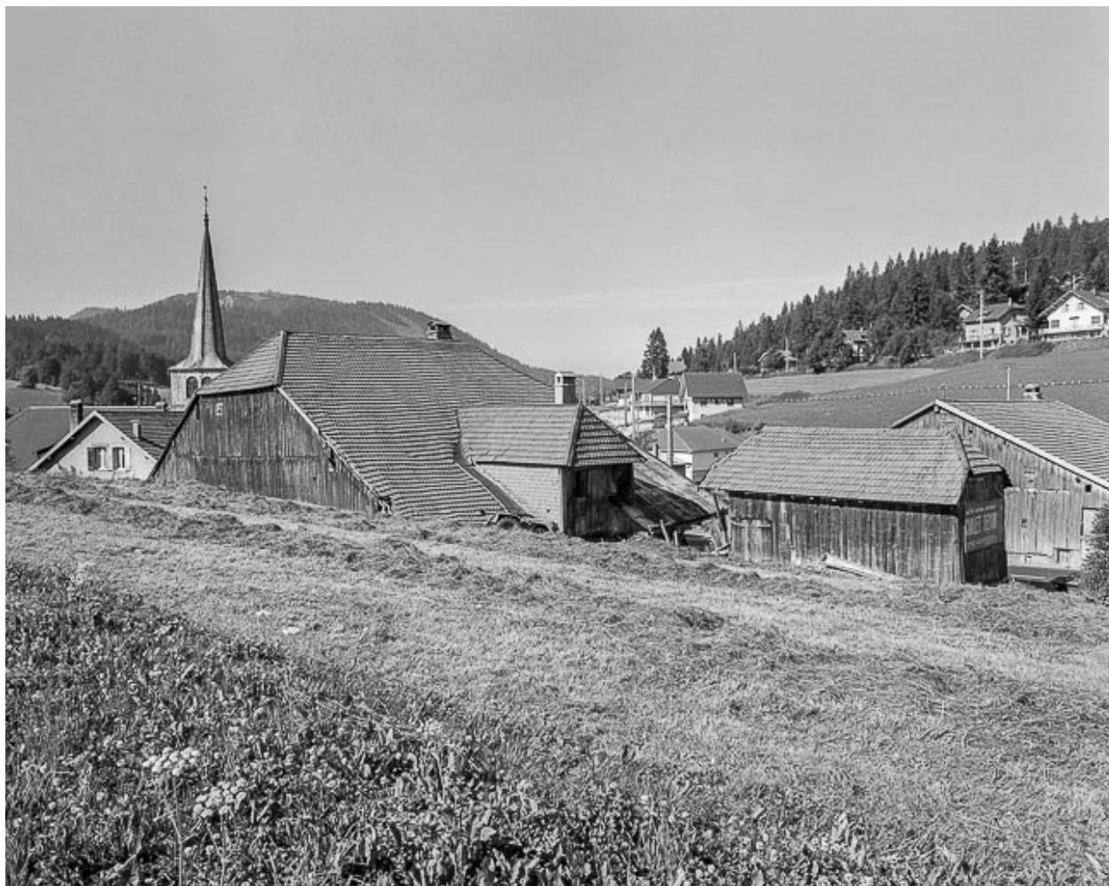
Façades postérieure et latérale gauche.
