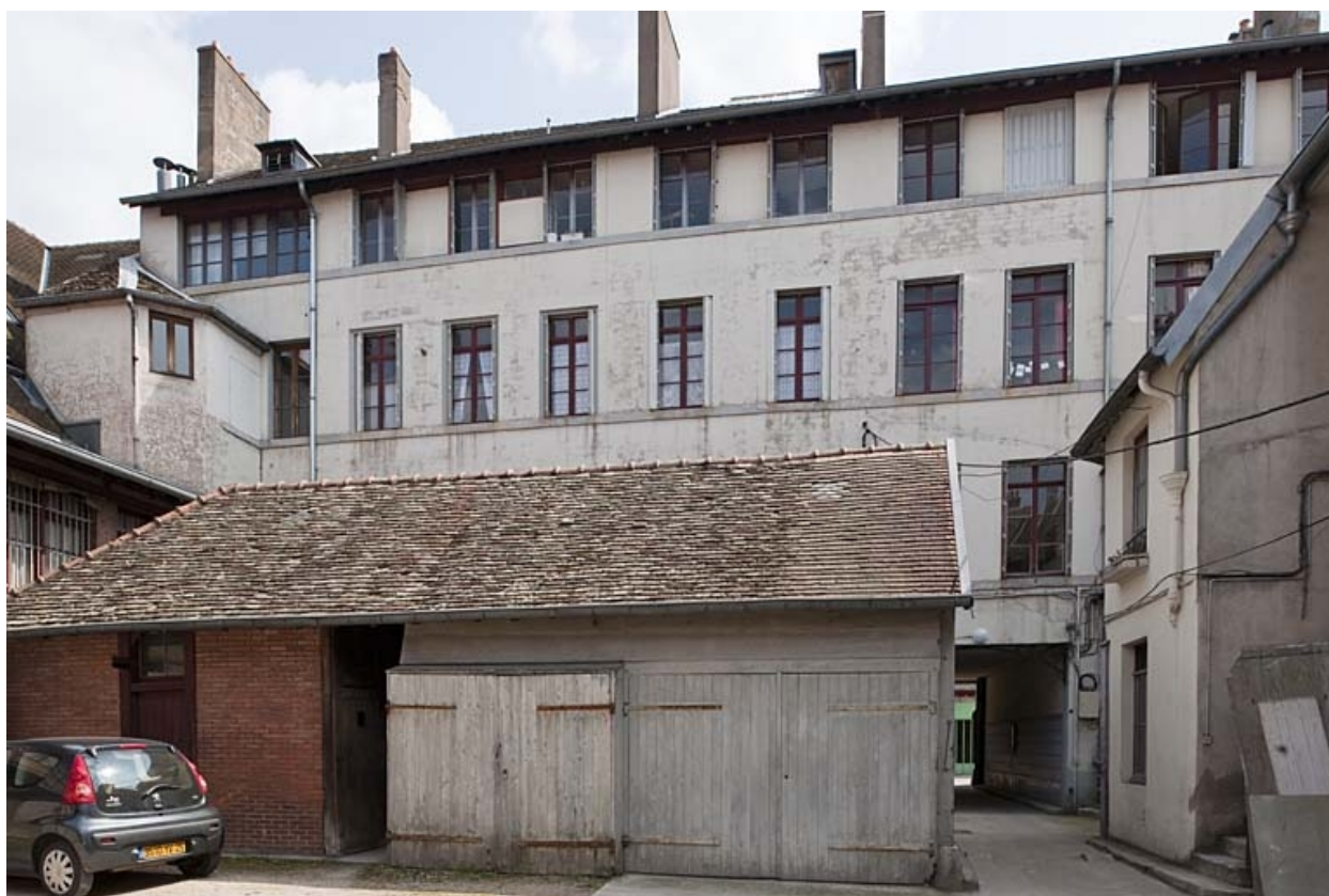
Façade postérieure de l'immeuble depuis la cour.
