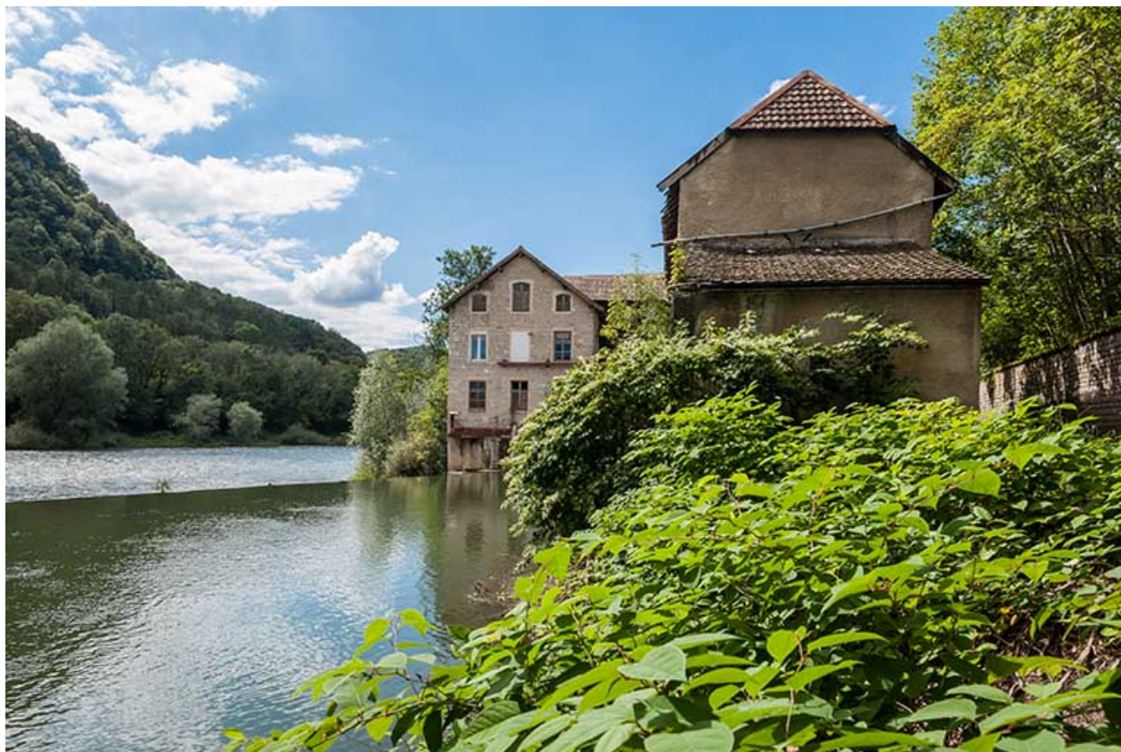
Moulin (sud) et magasin industriel depuis l'amont.
