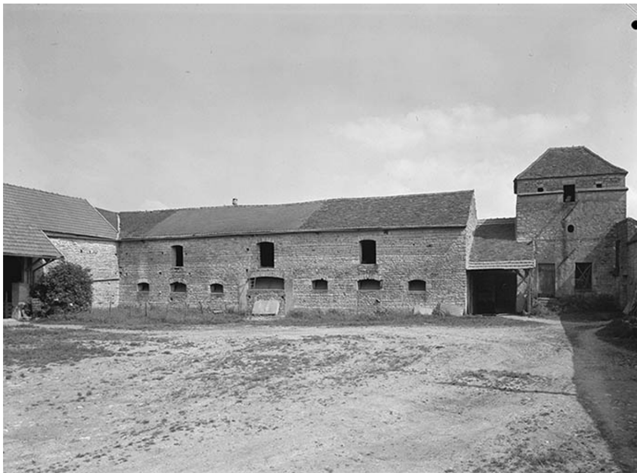
Corps de bâtiments sur cour.
