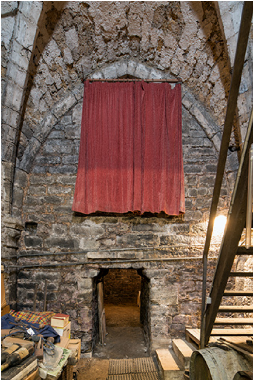
Cave du bâtiment sur rue. Mur ouest de la travée centrale.
