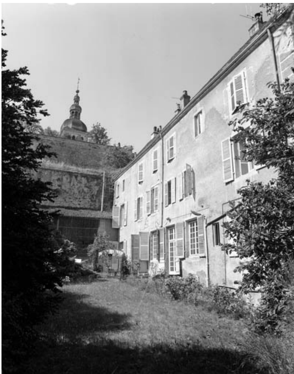
Façade postérieure de l'hôtel.
