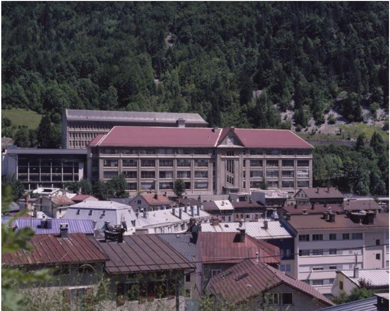
Bâtiment B : vue d'ensemble, depuis l'ouest.
