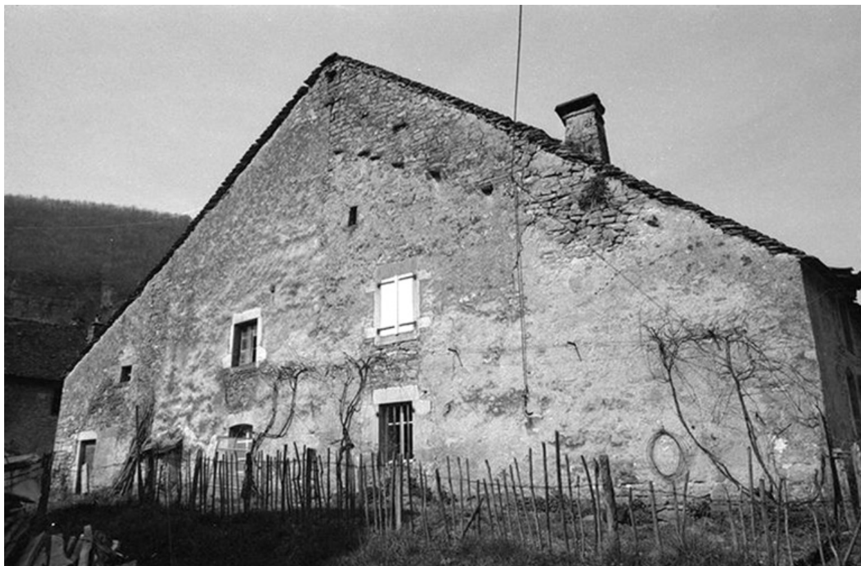
Ferme cadastrée 1964 AB 86 : façade sud.
