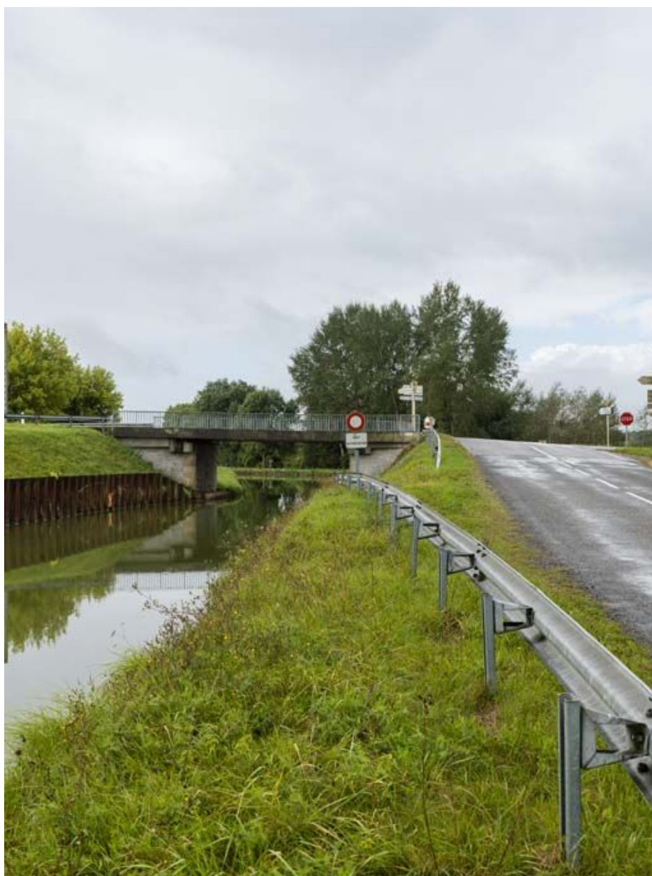
Vue d'ensemble du pont.
