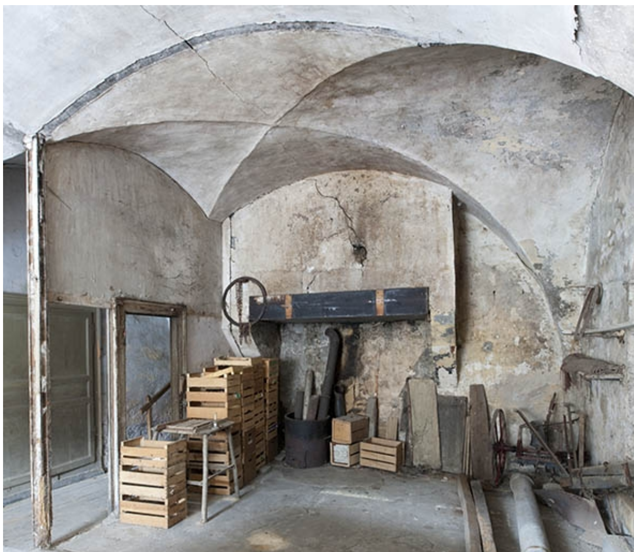
La cuisine et sa cheminée.
