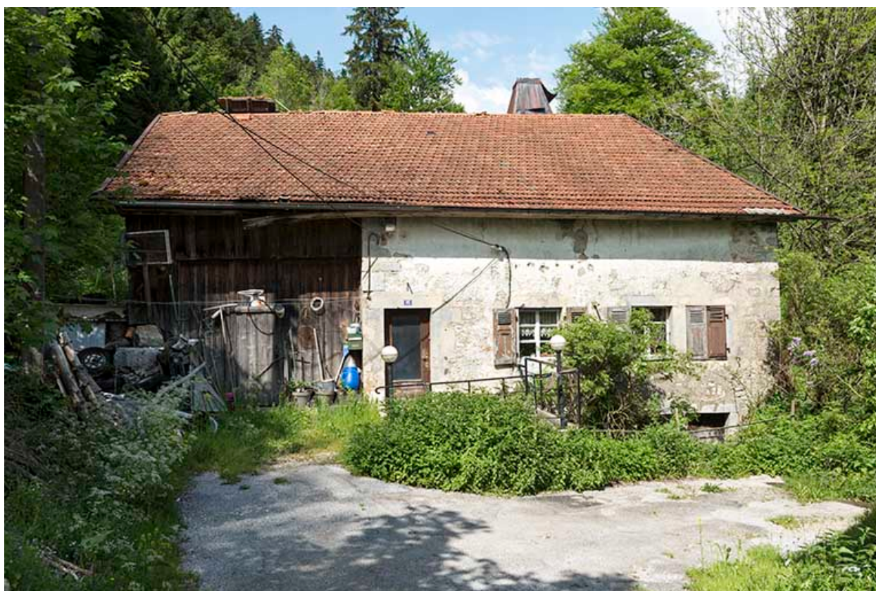
Ancien moulin : façade antérieure.
