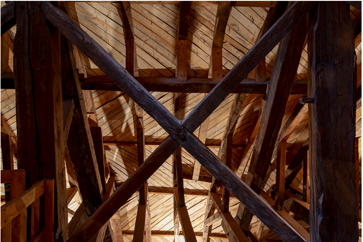
Partie nord depuis le niveau intermédiaire. Entretoise en croix de Saint-André.
