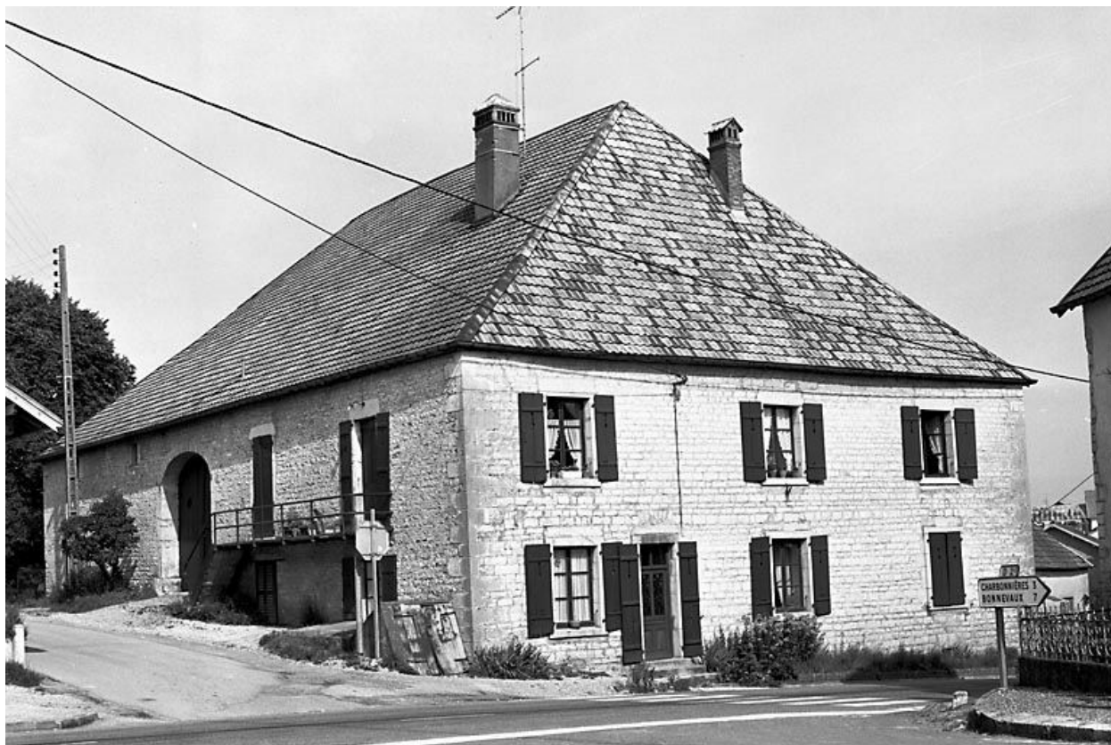
Ferme située à L'Hôpital-du-Grosbois.
