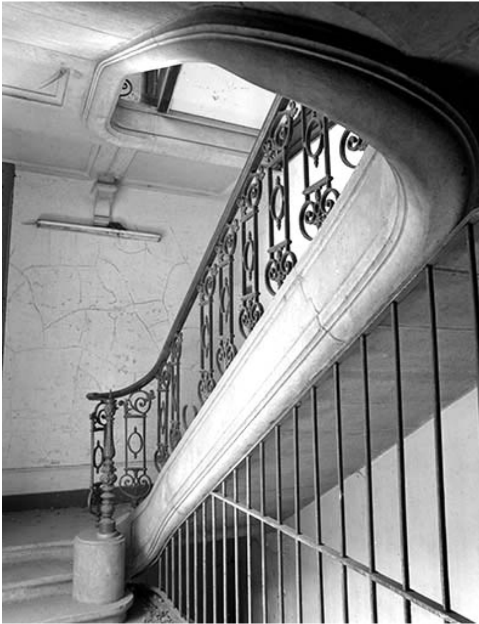
Escalier des bureaux (extrémité occidentale).
