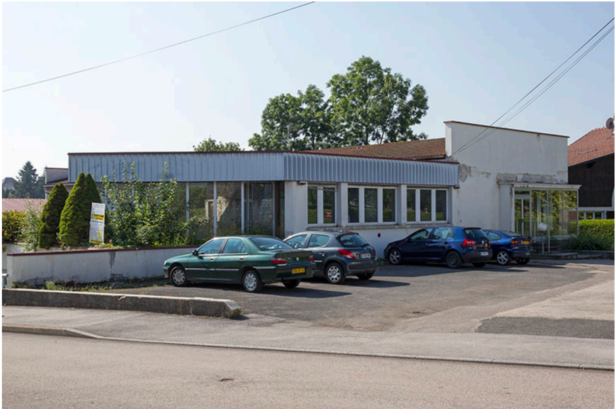
Usine, vue du nord-est : corps de bâtiment récent à gauche, ancien à droite.
