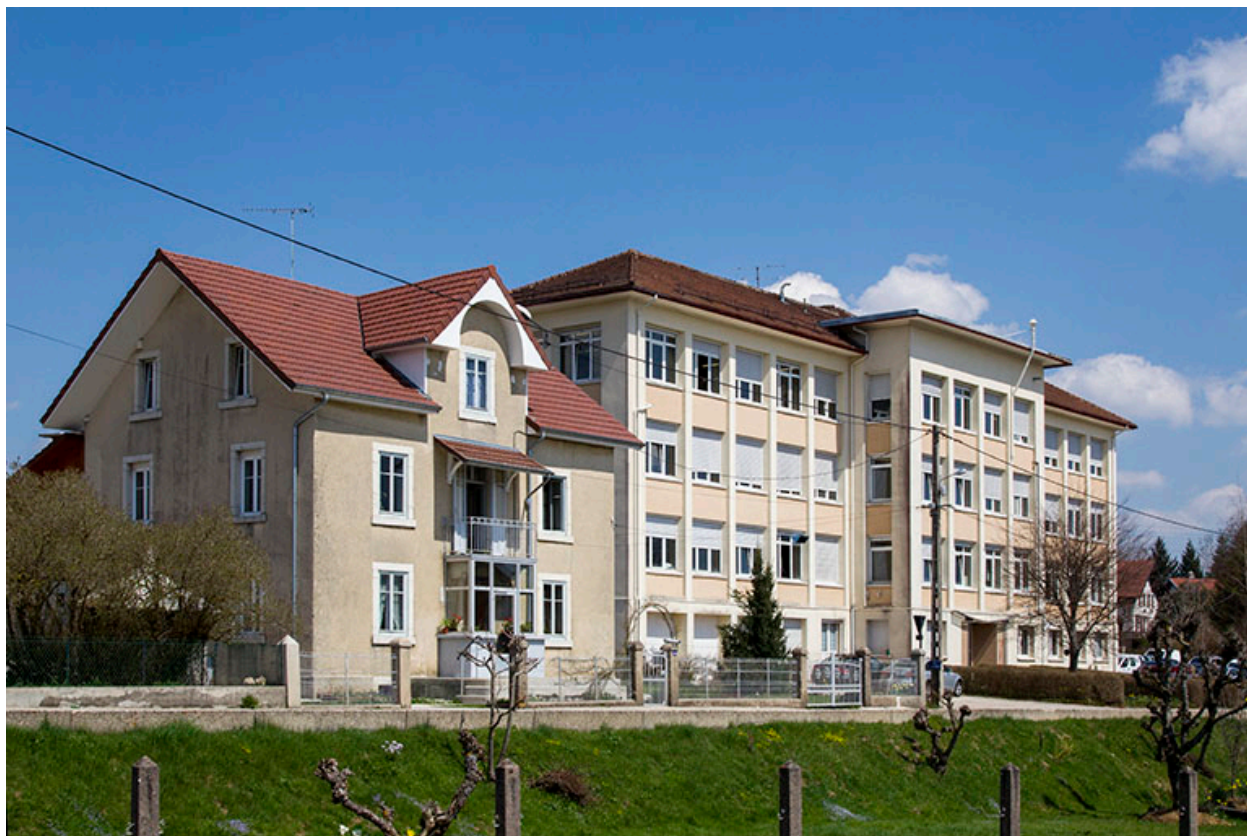
Façade antérieure, vue en enfilade depuis l'ouest.
