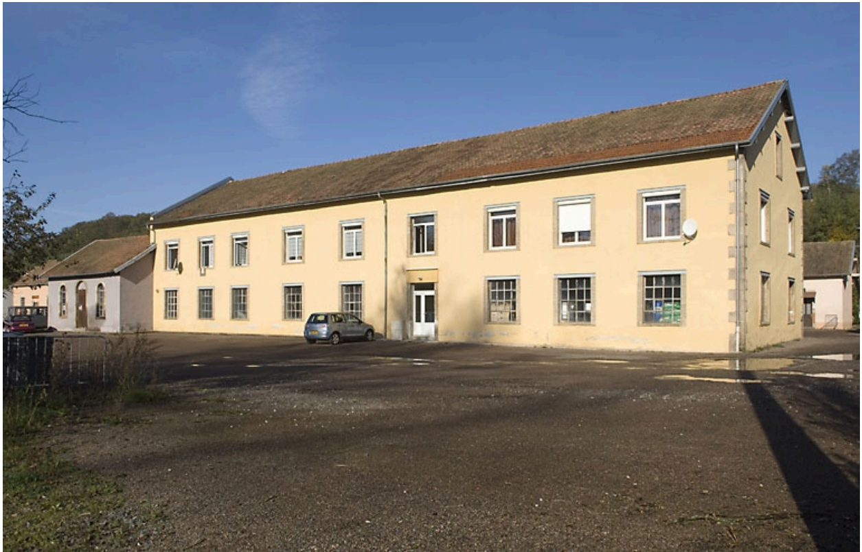
Atelier de fabrication sud (?).
