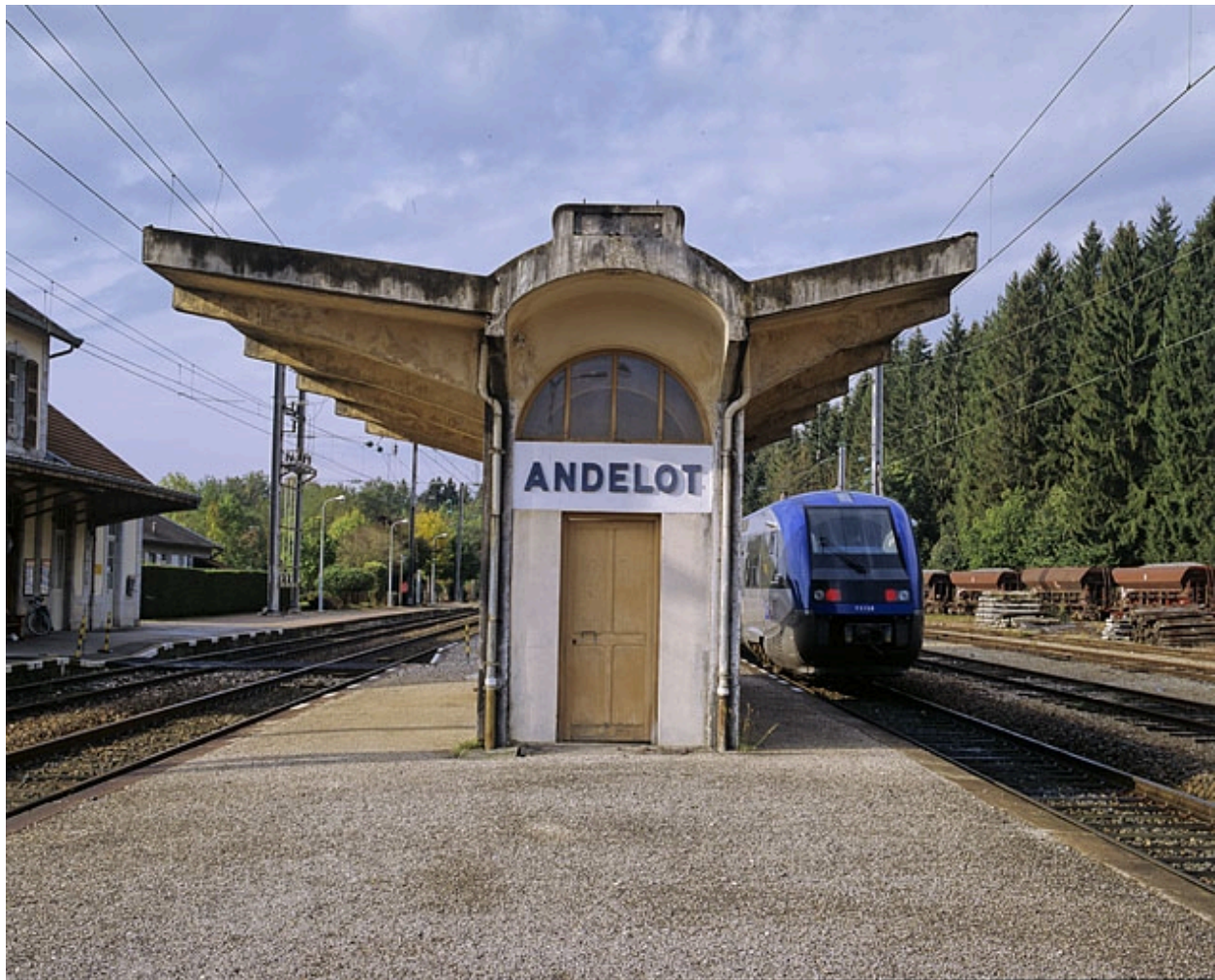
Abri de voyageurs, depuis le nord-est.
