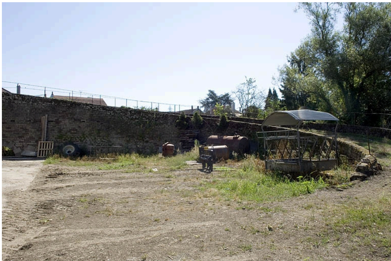
La rampe d'accès au pignon sud.
