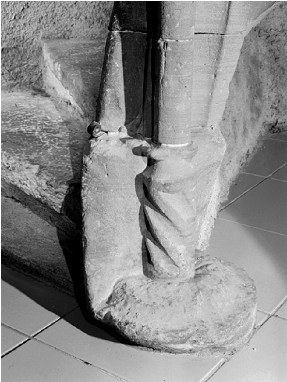
Escalier. Départ du noyau.
