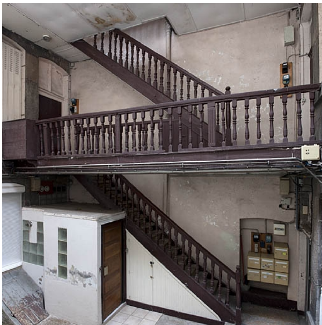
Vue d'ensemble de l'escalier à cage ouverte.
