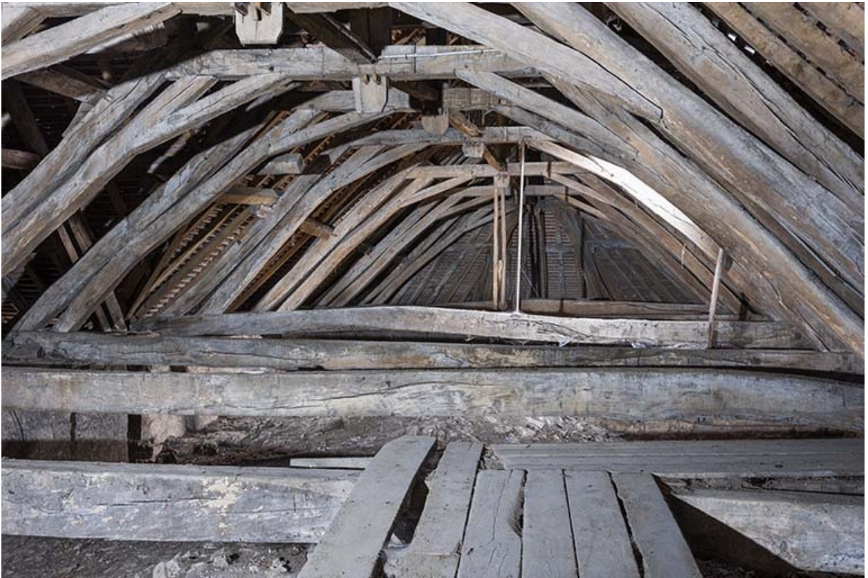
Autre vue de la charpente.
