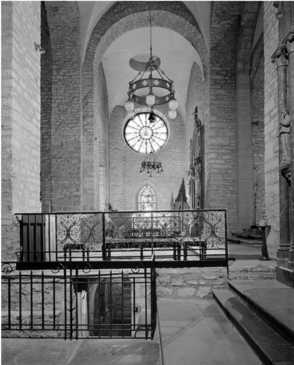
Eglise Saint-Désiré. Transfert vu depuis le bras sud.
