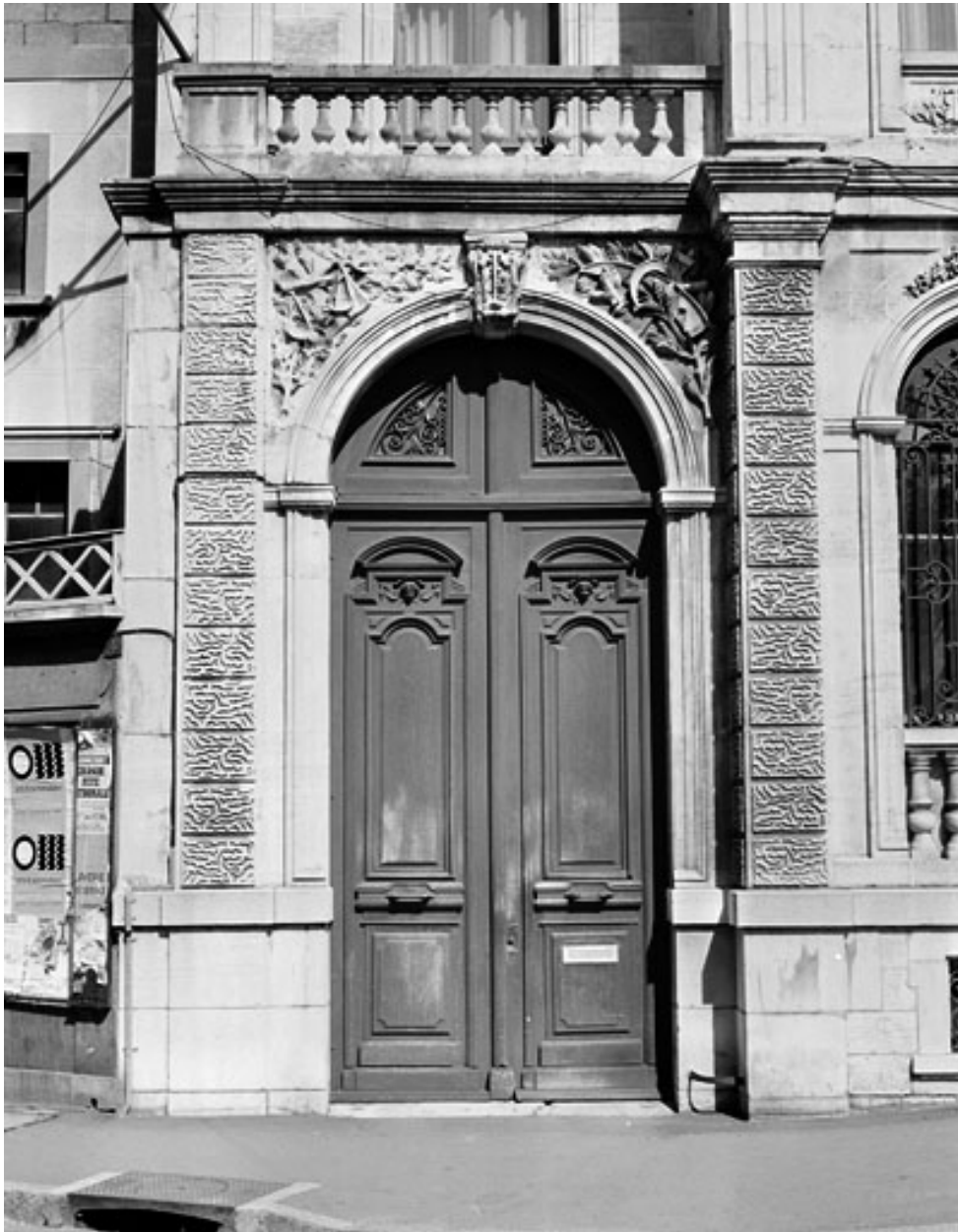
Banque. Façade principale, porte cochère.
