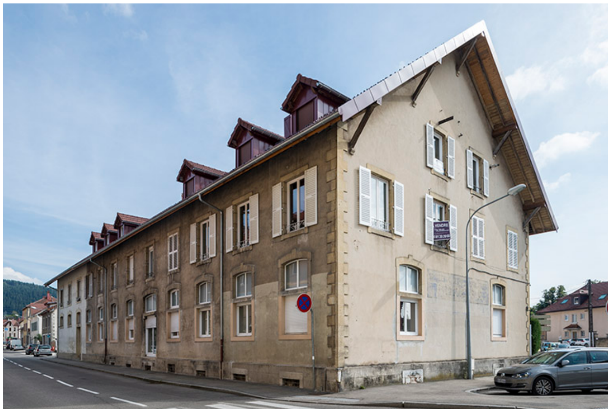
Façade nord et pignon ouest.
