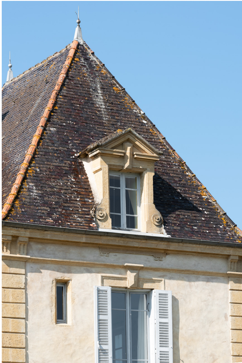
Vue de détail du pavillon nord-ouest vu de l'est.
