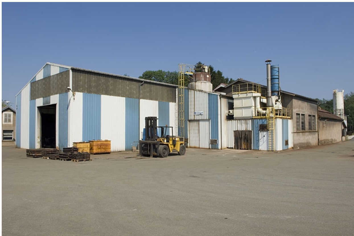
Le nouvel atelier de fonderie.
