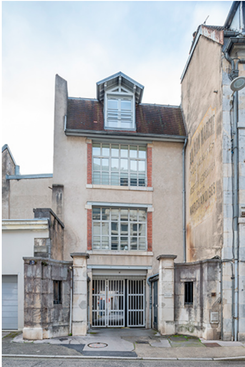
Bâtiment au 5 rue du Palais de Justice.
