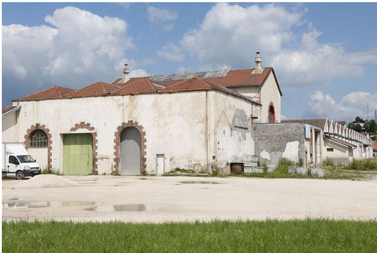
Salle des machines.
