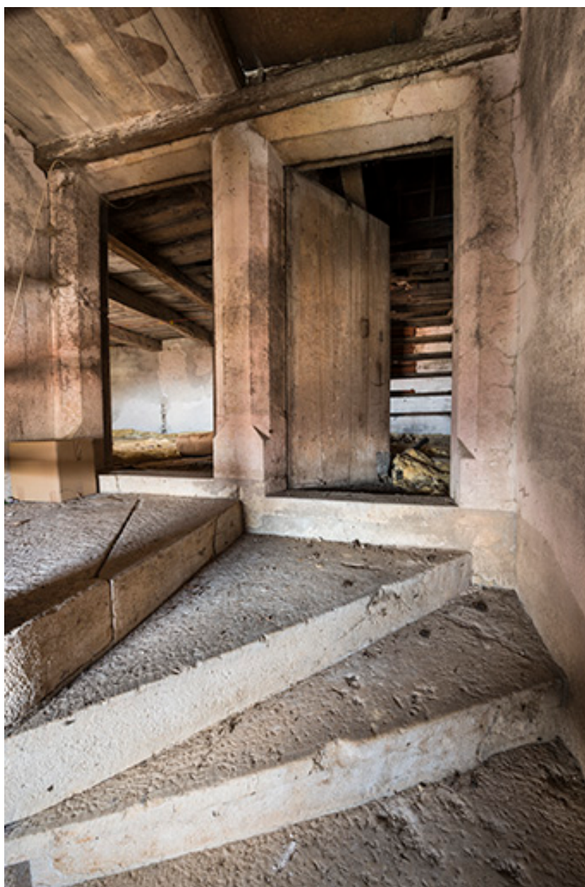
Portes d'accès aux combles depuis la tour.
