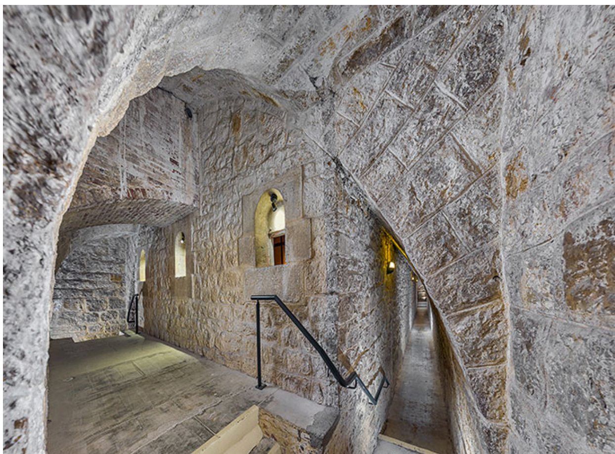
Le magasin à poudre. La galerie d'assainissement à droite et le vestibule d'éclairage à gauche.
