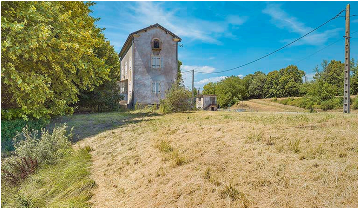
Pignon de la maison éclusière.
