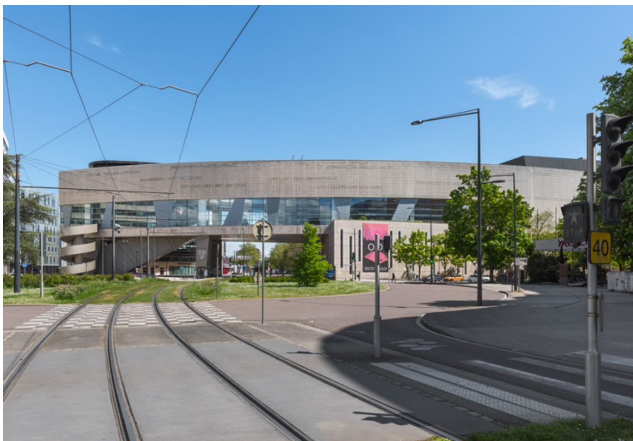
Vue d'ensemble (rapprochée), depuis l'ouest.
