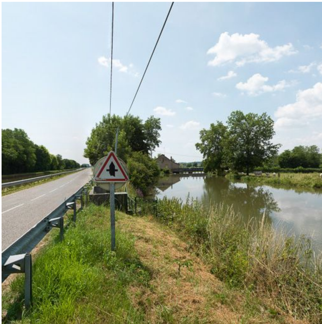
Détail de l'aqueduc.
