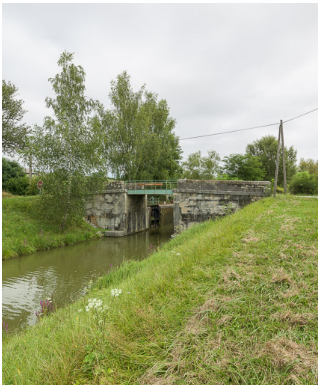
Vue d'ensemble du pont.
