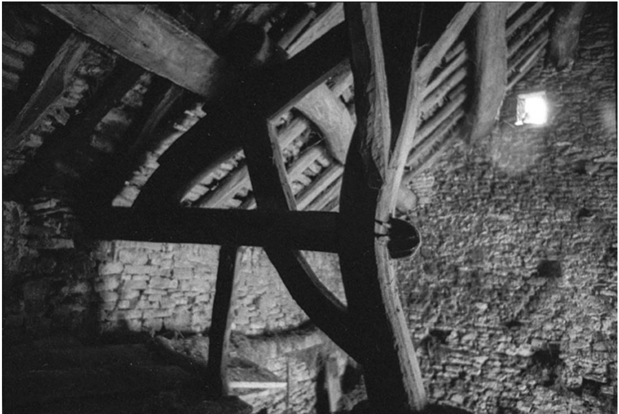
Ferme cadastrée 1960 B 107, située au lieudit La Peyrouse : détail de la charpente d'un toit en laves.
