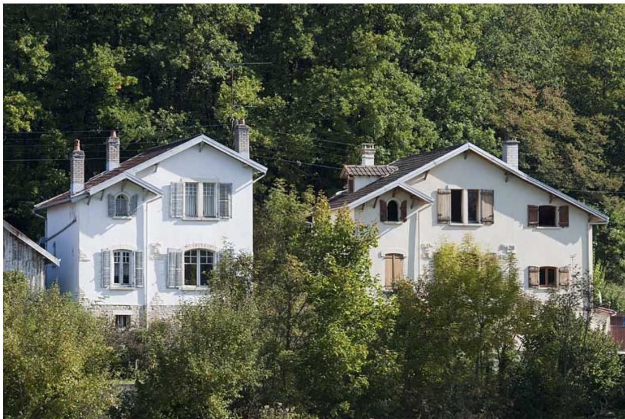
Maisons individuelles vues depuis l'ouest.
