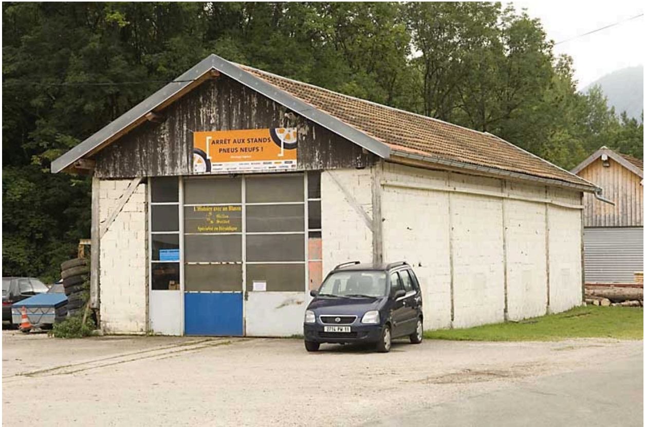
Partie sud : 1er bâtiment.
