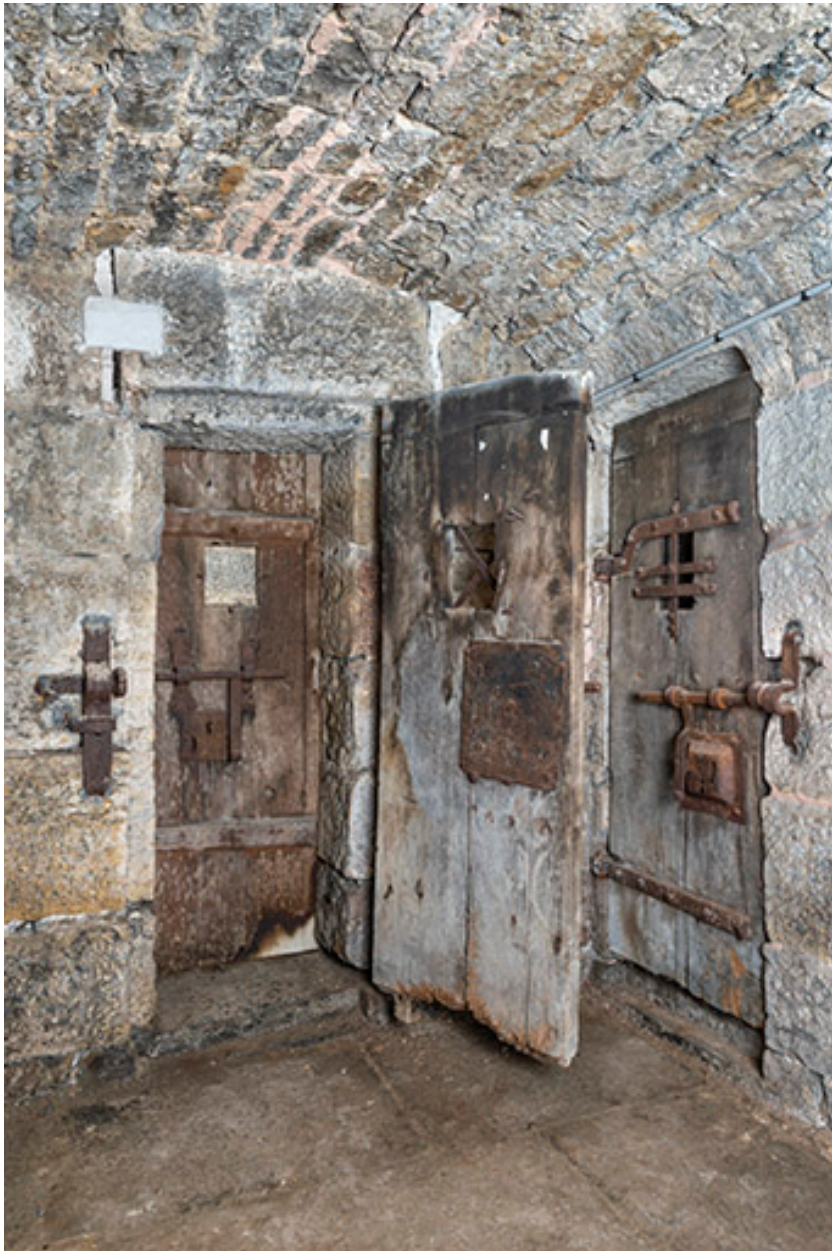
Cellules de l'angle sud-est.
