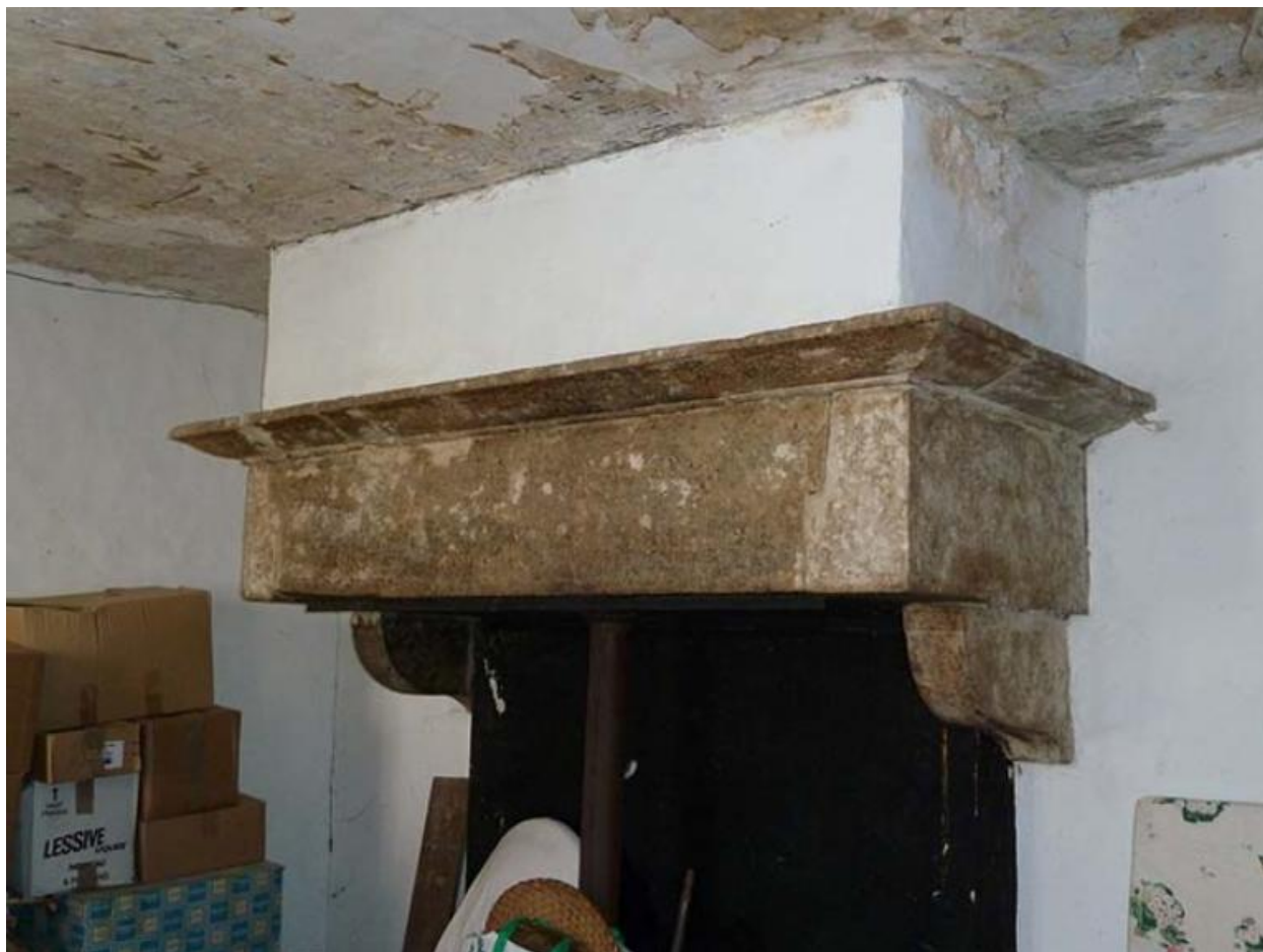
Cheminée de l'étage
