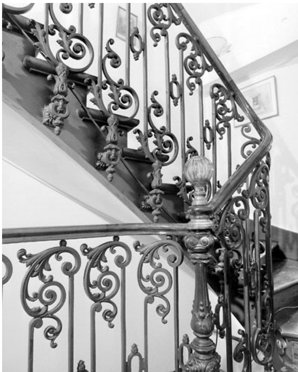
Escalier tournant : détail du garde-corps.
