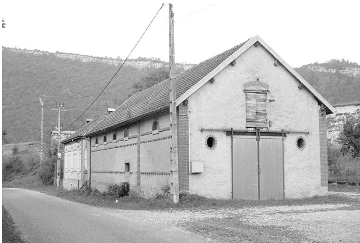
Les dépendances agricoles vues depuis la route.
