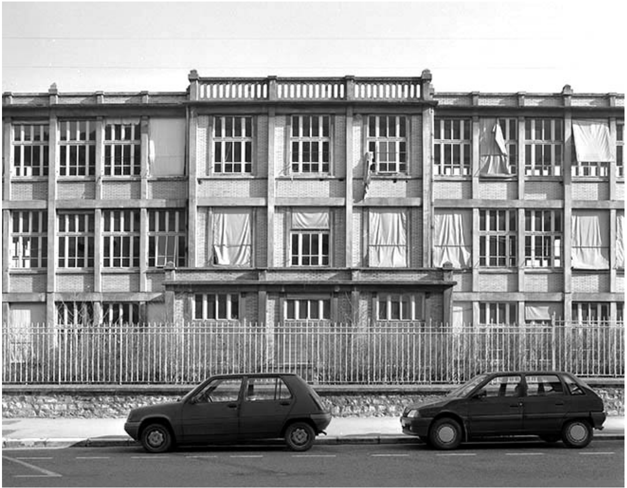
Détail de la façade antérieure (bâtiment 2c).
