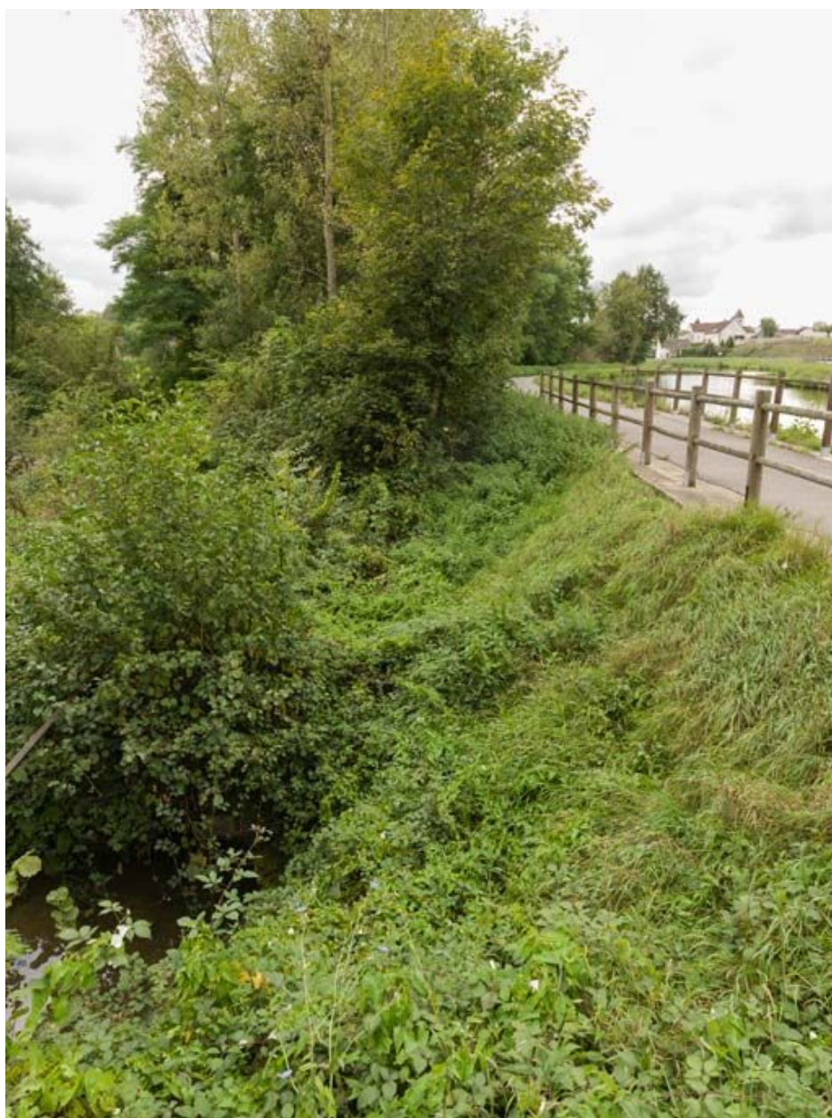
Vue de l'aqueduc.
