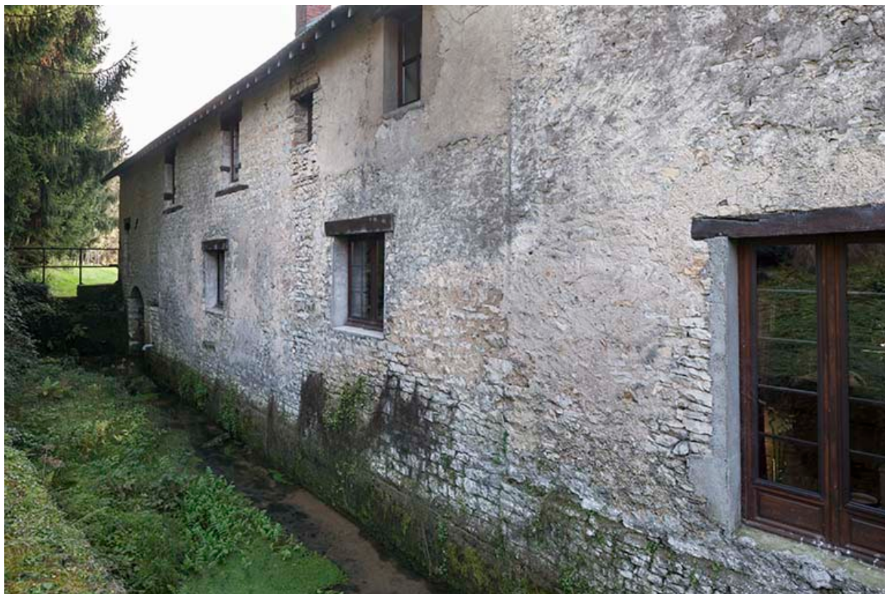
Façade est de l'atelier de forge.
