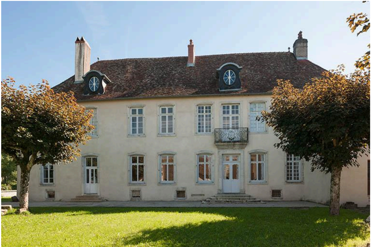
Demeure 13 rue Ménans, façade nord
