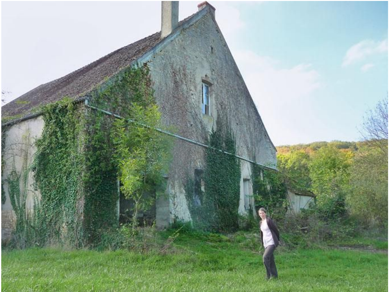
Mur gauche de la grange.
