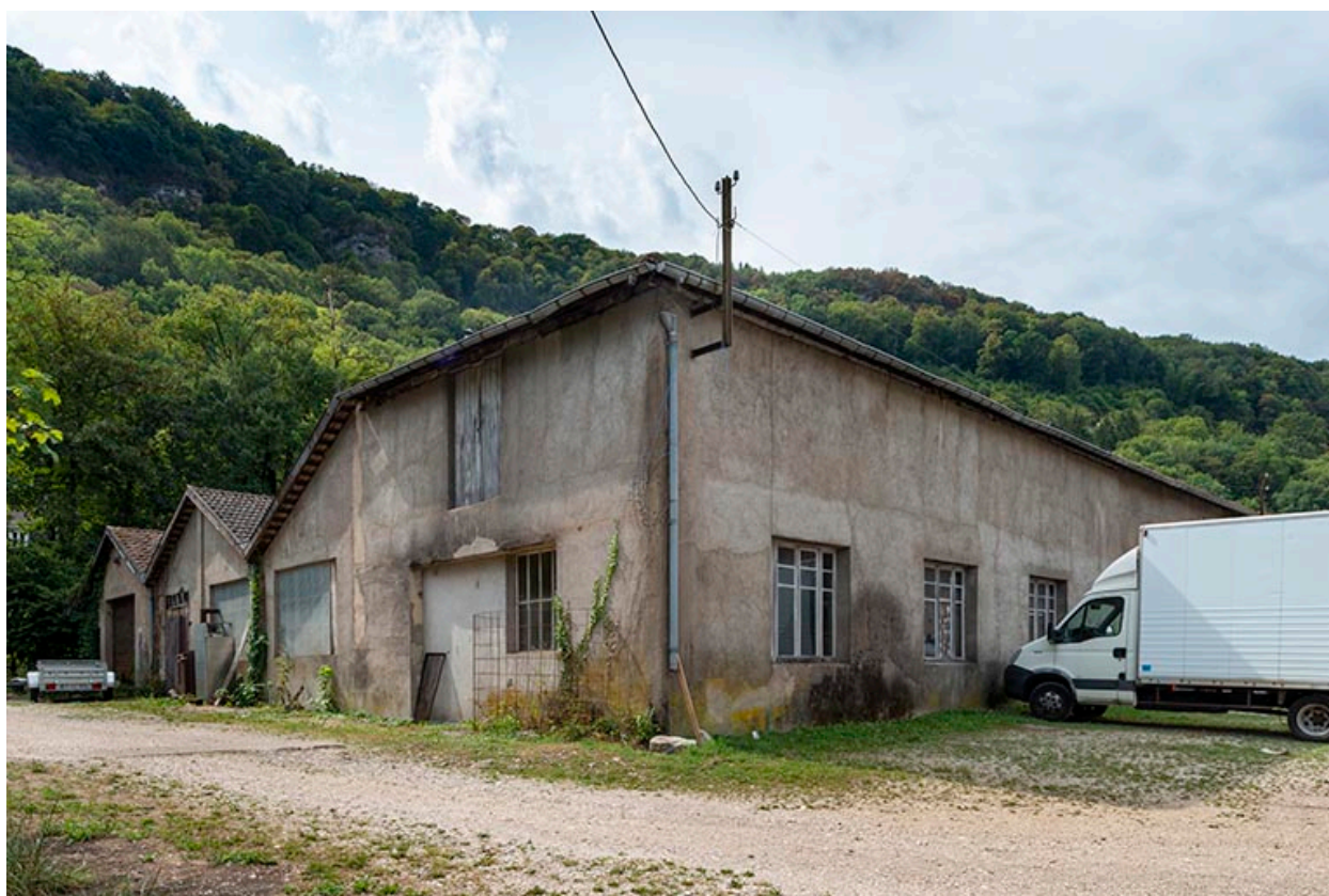
Garages et entrepôts industriels (faïencerie).
