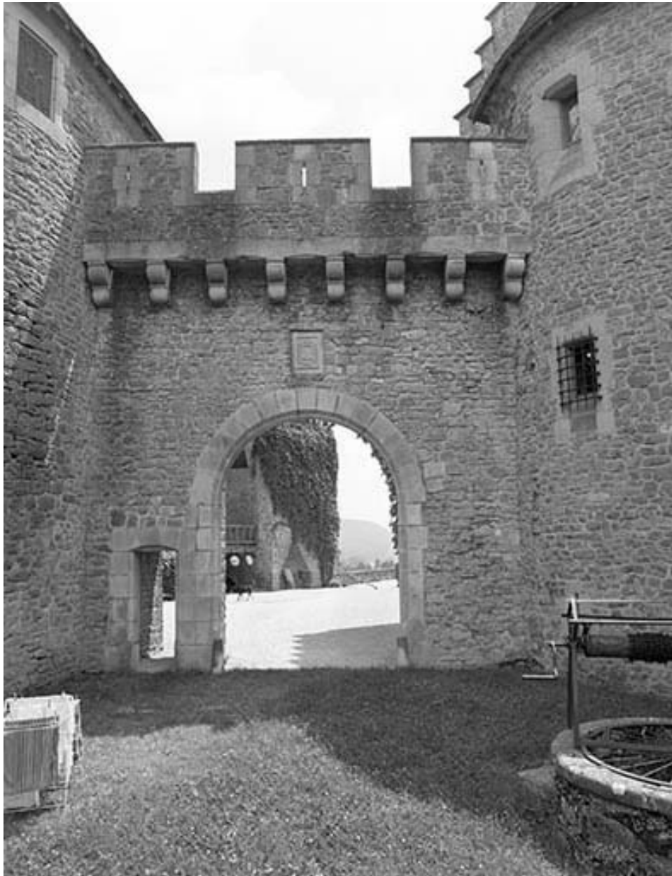
Portail nord : vue de face.
